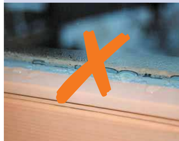
▲ Hygieneprobleme durch Tauwasser- oder Schimmelbildung am Glasrand werden durch sgg SWISSPACER stark reduziert
